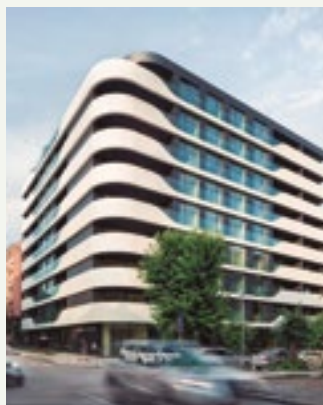
Nowoczesny budynek mieszkalny w Butgarri z efektywnym rozwiązaniem HVAC. Aquarea
